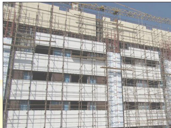
اجرای کامپوزیت نمای غربی
